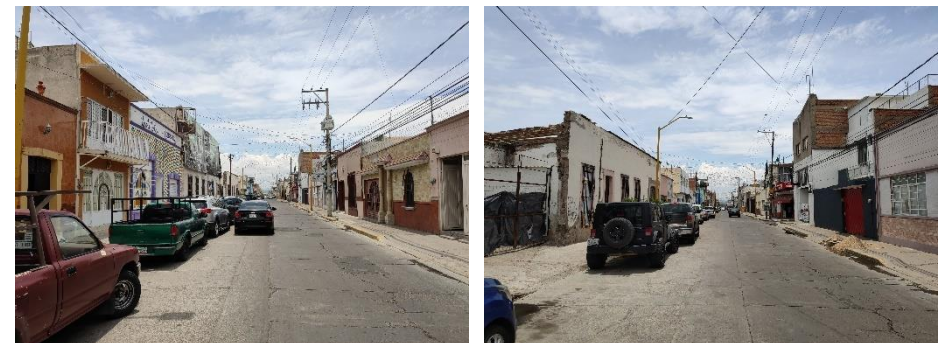
Figura 15 Ausencia de vegetación en vialidades
