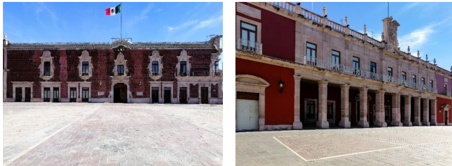
Fachada frontal y de posterior de Palacio de Gobierno Estatal; fachada frontal y de posterior de Palacio de Gobierno Municipal. Foto: IMPLAN, 2021.
