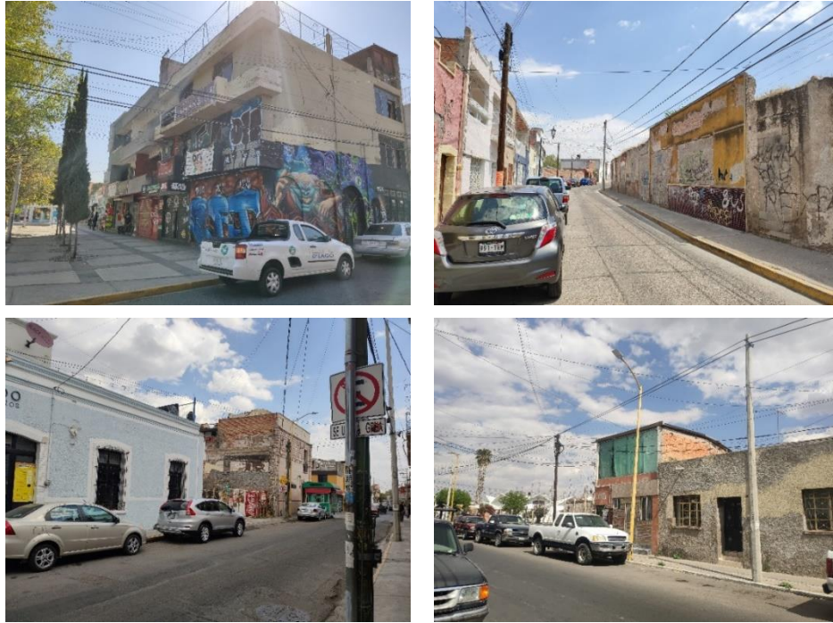
Figura 23 Morfología y estado de las edificaciones en la ZUFO Centro.
