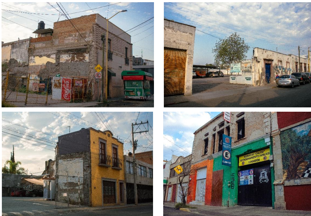
Figura 54 Estacionamientos públicos de pago con alteración en fachadas
